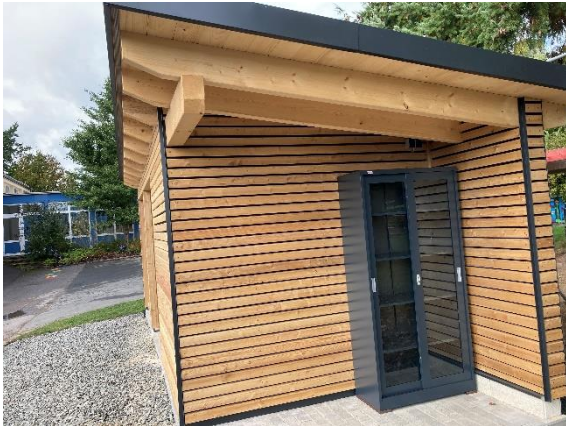
Unterstellhäuschen mit Bücherschrank, Foto: Anita Forster
